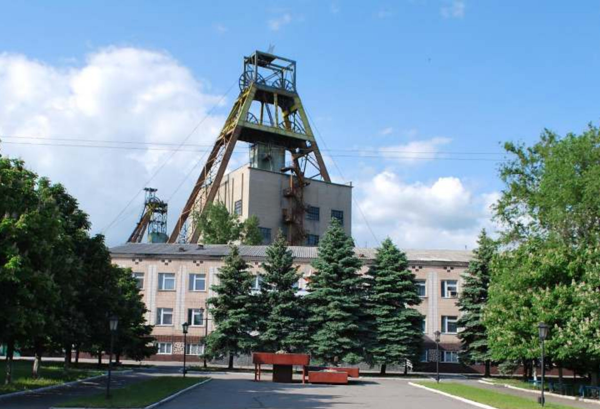
Адміністративна будівля «Шахти «Ударник» державного підприємства «Сніжнеантрацит». 2008 рік.
