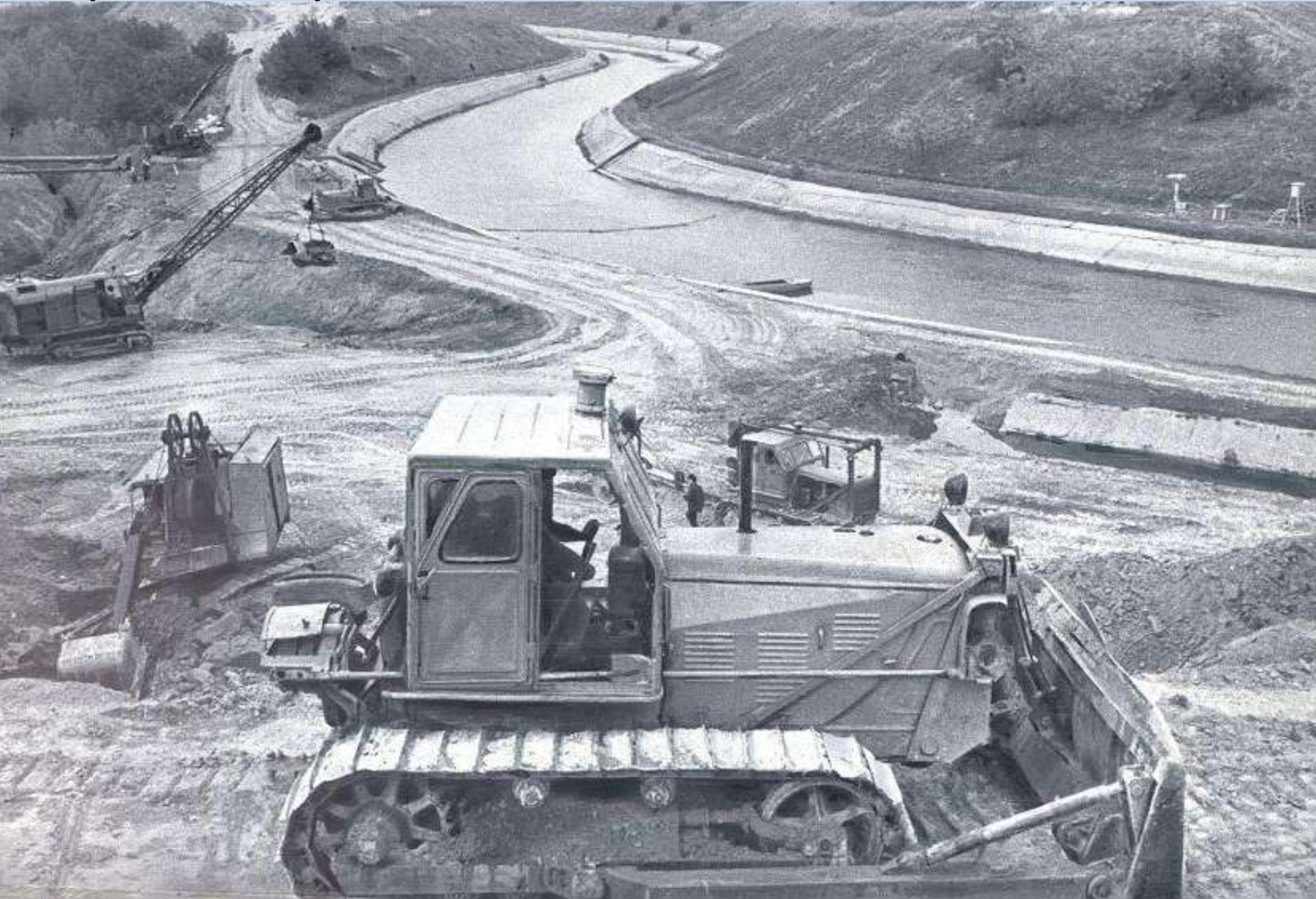
Будівництво другої черги каналу Сіверський Донець-Донбас в районі м.Горлівки. 1974 рік.
